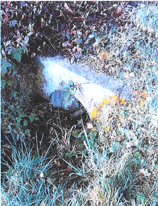
Tête d'aqueduc maçonnée
